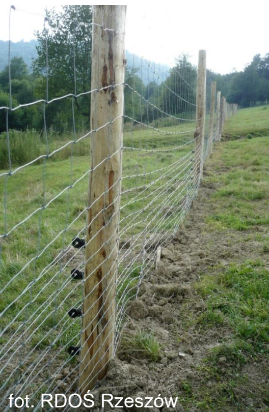
Zabezpieczenie zagrody za pomocą ogrodzenia z siatki leśnej
