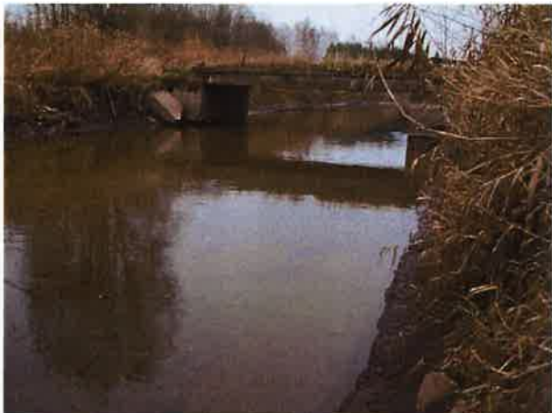
Fotografia nr 25. Most na drodze Brożajcie – Skalisko
