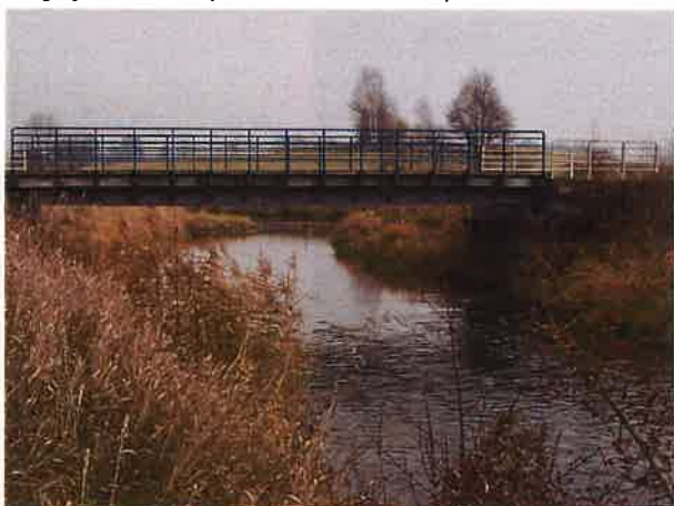
Fotografia nr 16. Nowy most na drodze Miczuły – Zakątcze Wielkie
