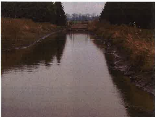
Fotografia nr 26. Widok z mostu (droga Brożajcie – Budzewo) na śluzę MEW w Brożajciach
