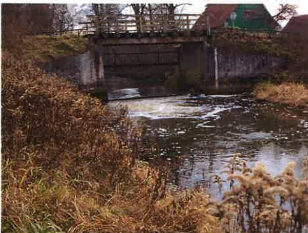
Fotografia nr 20. Most z progiem wodnym przy leśniczówce Bąkowo
