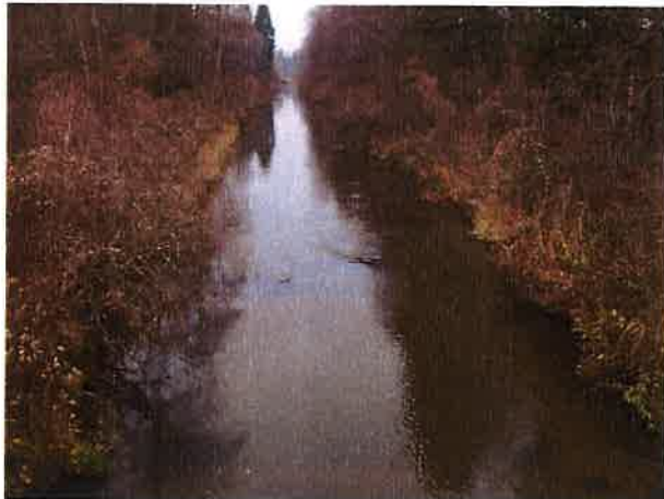
Fotografia nr 24. Widok kanału z mostu na drodze Banie Mazurskie – Skalisko
